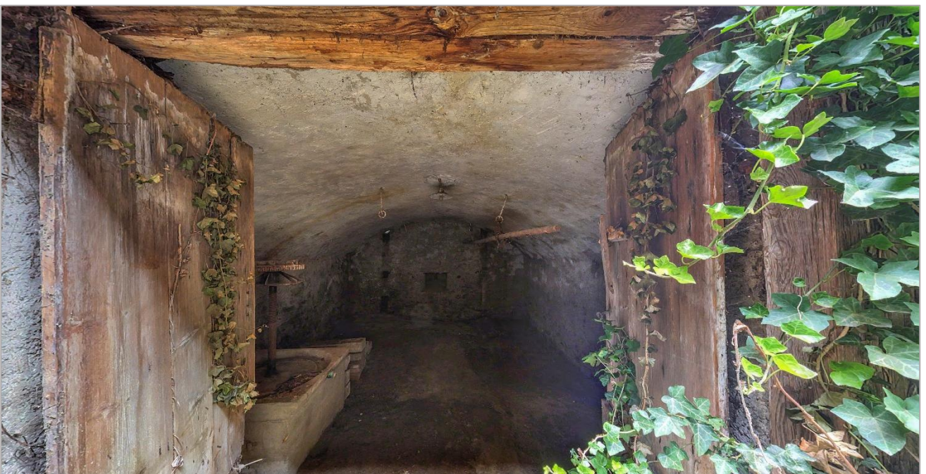
Blick in den alten Gewölbekeller
